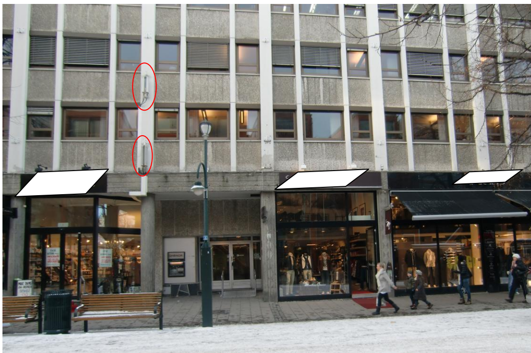
Figur 8.1: Eksempel på fasademonterte mobilantenner der de høyeste måleverdiene ble funnet, men som ikke nødvendigvis er representative for det aktuelle området eller tilsvarende områder. Også her lå måleverdiene godt under grenseverdiene. Antenner for GSM/UMTS er markert med røde ringer på fasaden. Foto: Nils Tapio, Post- og teletilsynet.
