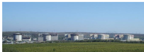
Cernavodă kjernekraftverk. Foto:DSA.
