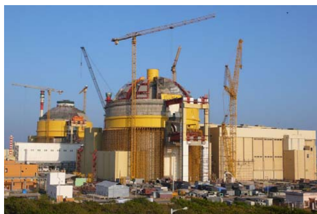
Kjernekraftverk under bygging i India. Foto: Petr Pavlicek/IAEA.
