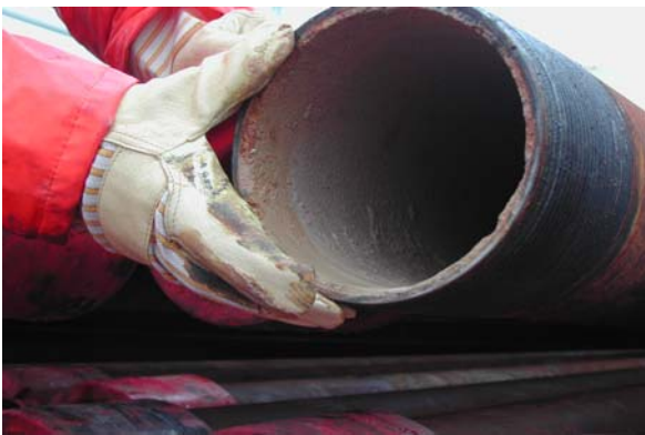
Scaleavleiringer i et produksjonsrør
