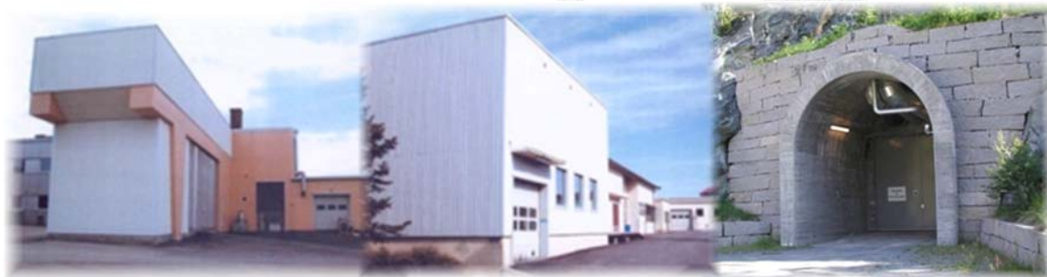
Lageranlegg for radioaktivt avfall og brukt brensel i Norge (fra venstre IFEs anlegg i Halden, IFEs anlegg på Kjeller og Statsbyggs kombinerte deponi og lager i Himdalen)
