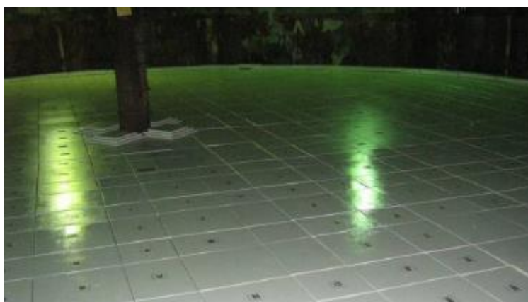
En lagringstank for brukt brensel før og etter rehabilitering ved blyskjerming.
