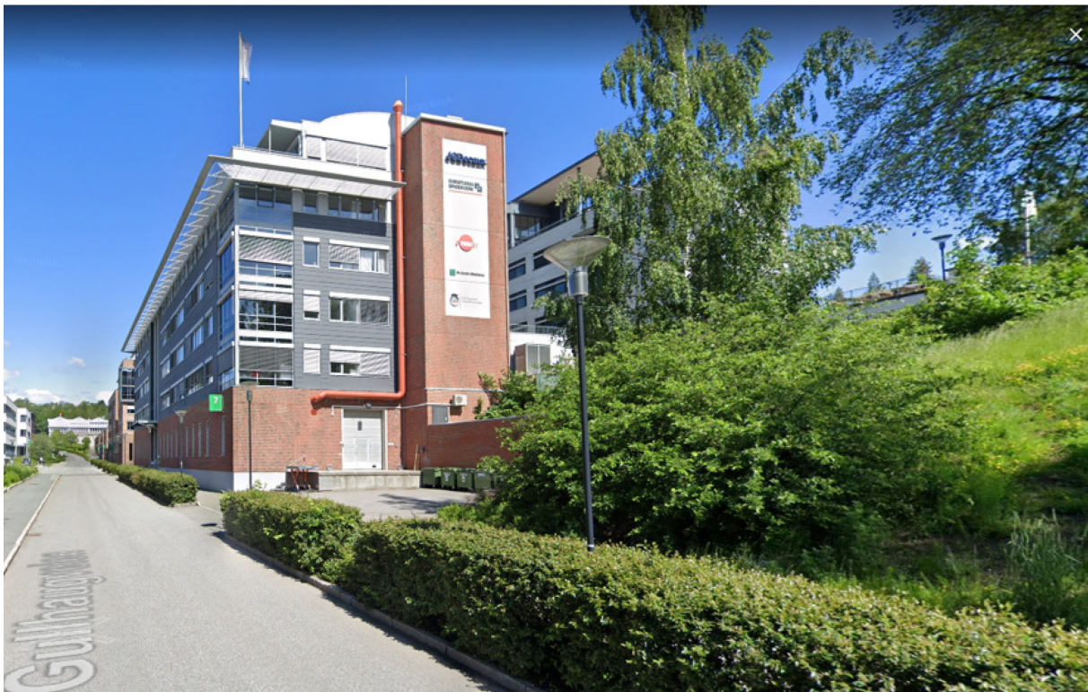
Figur 2: Oncoinvent sitt lokale i Gullhaugsveien 7 i Nydalen. Utslippet ledes gjennom røret, som kommer ut fra laboratedelen i grunnetasjen og ledes opp langs veggen, og slippes så ut på taket. Merk takterrassen med delvis tak til venstre. Også utløpet for det generelle ventilasjonsanlegget kan sees nede til høyre på bygget.
