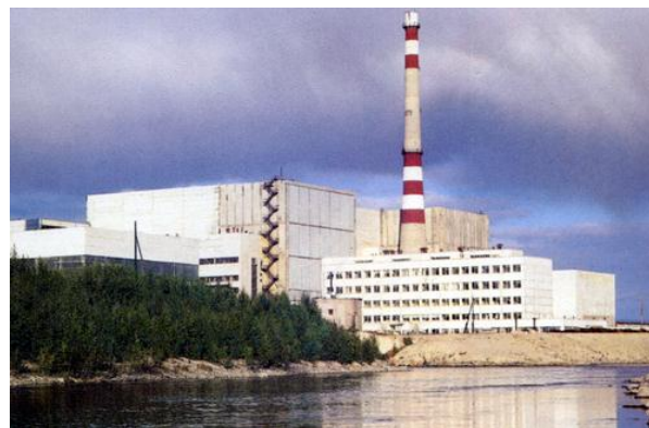
Kola kjernekraftverk (Foto: Statens strålevern).
