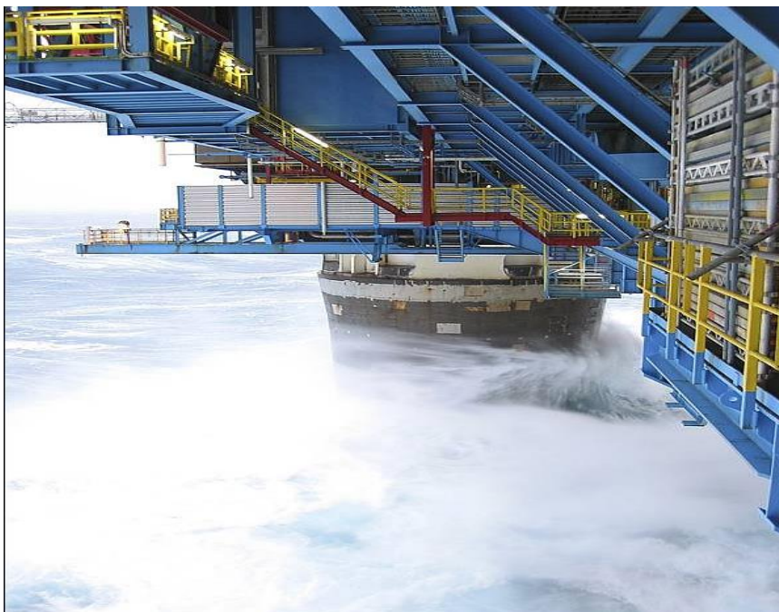
Figur 5.3 Mange radioaktive kilder er montert offshore. Disse kan stå relativt ubeskyttet og må være konstruert for å tåle store påkjenninger. Foto: Statoil.
