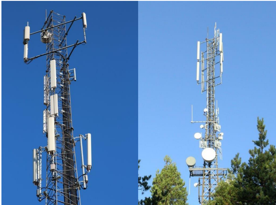
Figur 8.4 Basestasjoner for mobiltelefoni (t.v.) og mast med flere tjenester(t.h.). Foto: Statens strålevern.
