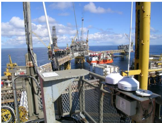
Foto 4-3 Måling av UV på hotellplattformen på Ekofisk. UV-instrumentet var midlertidig tatt ned da bildet ble tatt, men detektor understellet ses som en hvit tallerken foran den gule masta. Foto: Kjetil Stiansen, MET.NO.
