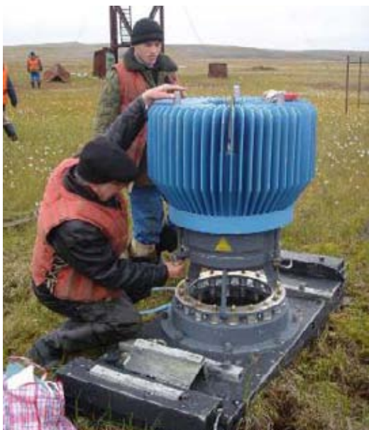
Рис.2. Подготовка РИТЭГ к демонтажу. Указанные работы проводятся обученным персоналом эксплуатирующей организации. На проведение этих работ оформляется наряд-допуск.
