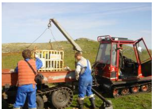
Рис.2. Подготовка РИТЭГ к демонтажу. Указанные работы проводятся обученным персоналом эксплуатирующей организации. На проведение этих работ оформляется наряд-допуск.
