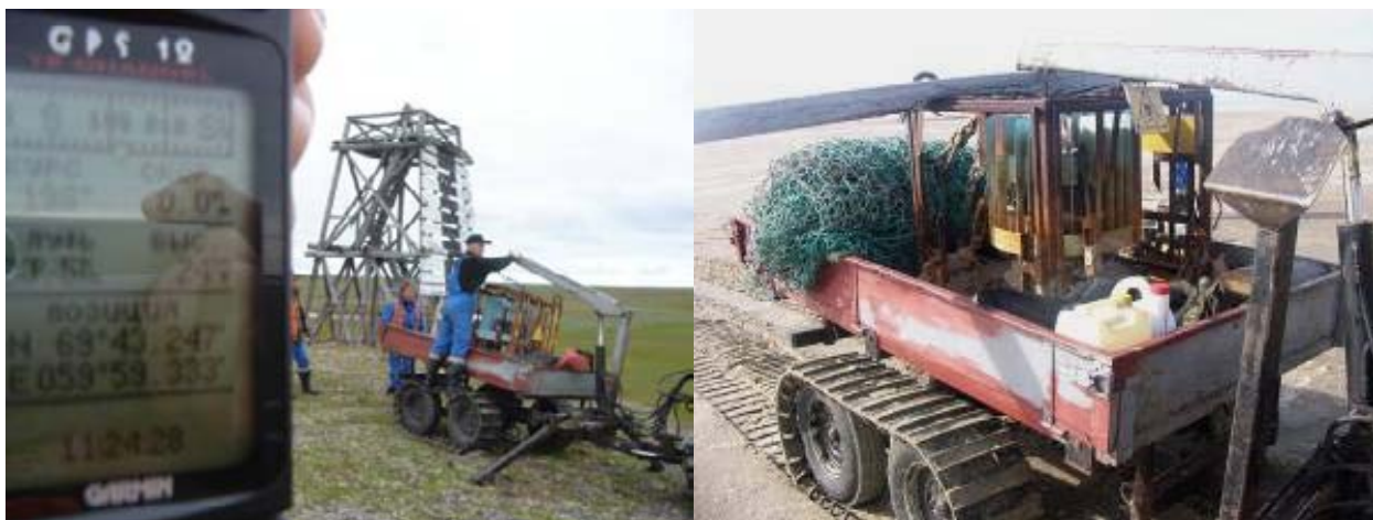
Рис. 3. Демонтаж РИТЭГ и размещение его на транспортном средстве для доставки к месту его погрузки на плашкоут. Демонтаж каждого РИТЭГ оформляется актом, подписываемым лицами, проводившими демонтаж, и утверждается руководителем эксплуатирующей организации.
