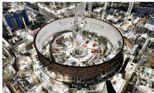
Hinkley Point C under bygging. Foto: EDF
