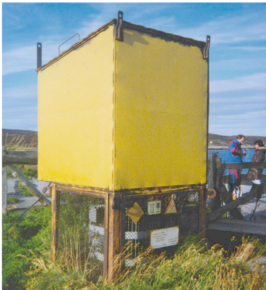
En RTG med innkapsling og strømforskyning. Foto: Statens strålevern
