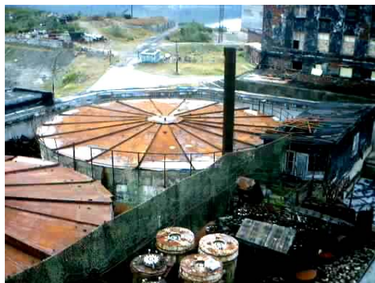
Lagringstank 2 og 3 for brukt kjernebrensel (Foto: SevRao).
