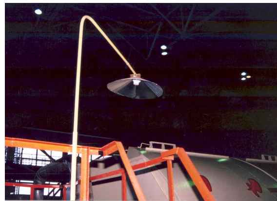
Røykdetektor installert i et norsk/svensk prosjekt ved Ignalina kjernekraftverk (Foto: Statens strålevern)
