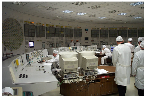
Fra kontrollrom ved Leningrad kjernekraftverk (Foto: Statens strålevern).
