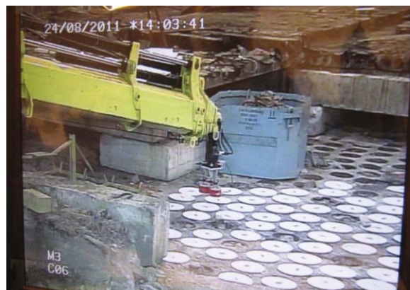
Lagringstank for brukt brensel. Norge har finansiert strålingsskjermingen av denne tanken sammen med Storbritannia. Foto: SevRao
