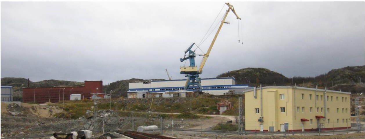
Et omfattende rehabiliteringsarbeid er i gang i Andrejevbukta. Foto: SevRao
