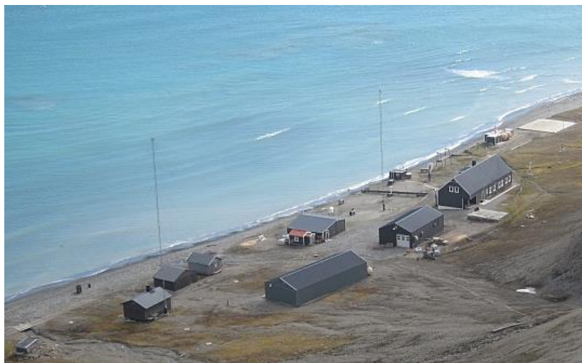
Bilde 7: Hopen meteorologiske stasjon. Foto: Meteorologisk institutt.
