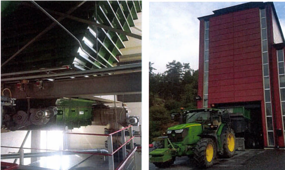
Bilde 16: Oversiktsbilde av slamsilo.
