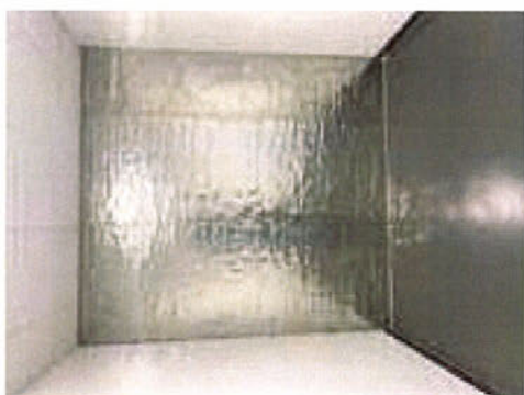
Figur 4: Etterskjermet vegg med 2 mm bly i lageret som ligger inn mot nukleærmedisinsk lager.
