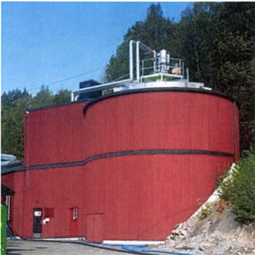
Bilde 14: Oversiktsbilde av råtnetanker.
