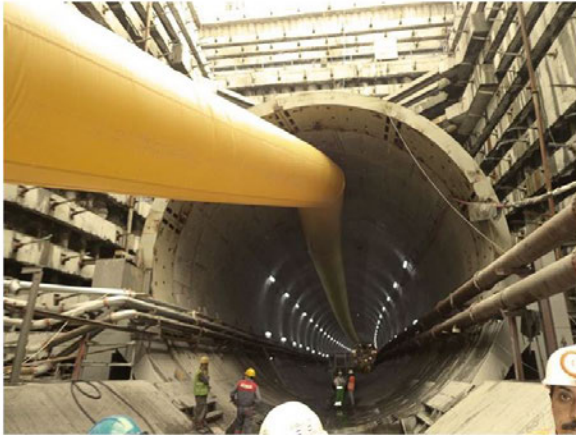
Eksempler på tvungen tunnelventilasjon
