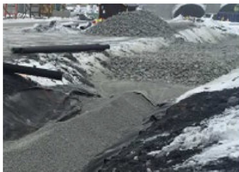
Figur 39. Oppbygging av drensledning langs veg over masselager.
