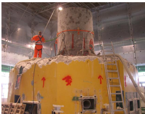
Riving av forskningsreaktoren DR2 ved Risø, Danmark (Foto: Dansk Dekommissionering)
