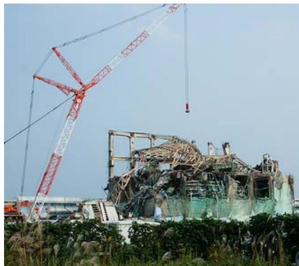
Reaktorenhet nr. 3 på Fukushima kjernekraftverk etter tsunamikatastrofen som rammet kraftverket i mars 2011. Kjernekraftverket ligger langt fra Norge, men hendelsen måtte håndteres også her. Foto: Giovanni Verlini/IAEA
